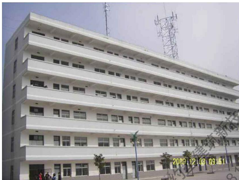
图 5.2 某中学教学楼实景图
