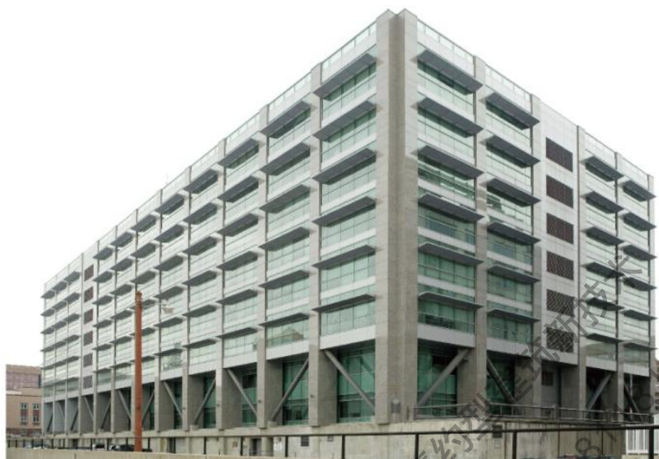
图 4.1 华莱士班尼特联邦大厦加固实景图
