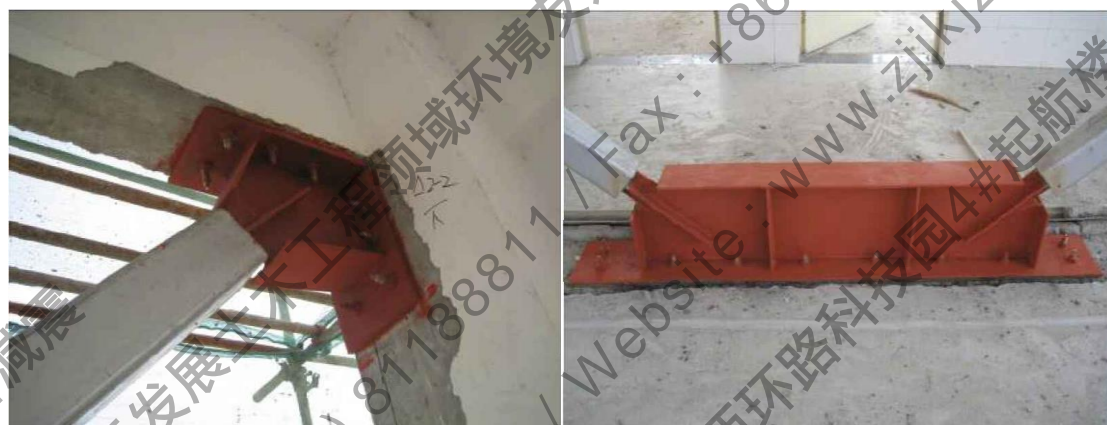
a)梁底化学锚栓施工
