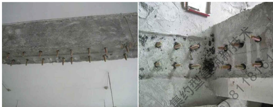
a)梁底化学锚栓施工
